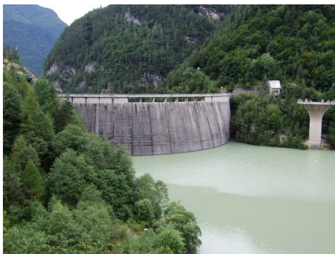
Figura 49 - diga di Pontesei, (Fonte: http://picasaweb.google.com/lh/photo/pvRdb_11dkF4M9BqhcEyag )
